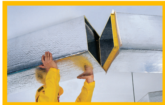
Prefabrik Klima Kanallarının birbirine eklenmesi
