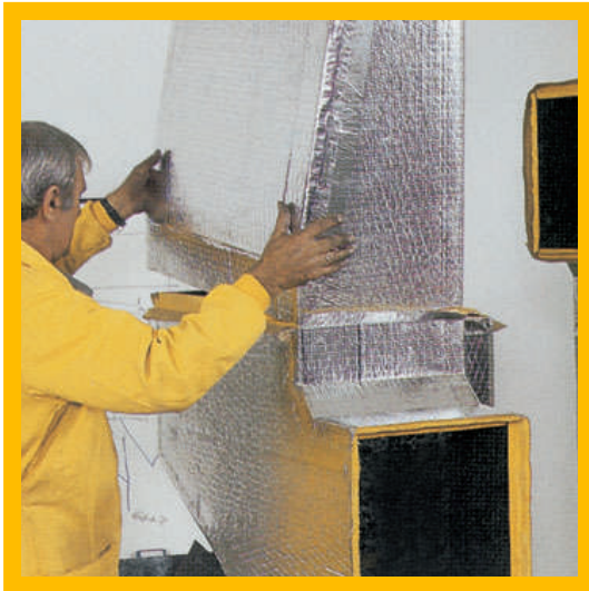
Prefabrik Klima Kanallarının birbirine eklenmesi
