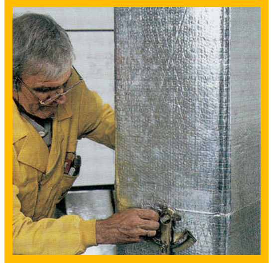
Prefabrik Klima Kanallarının hava damper montajının yapılması
