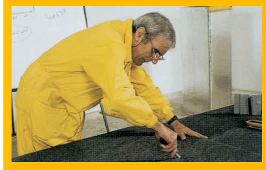
Prefabrik Klima Kanalı Levhalarının işaretlenip kesilmesi
