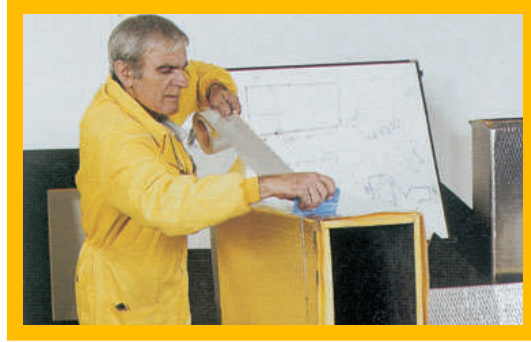
Kesim işleminden sonra, levhaların katlanıp birleştirilen kenar üzerinden zımbalama yapılması
