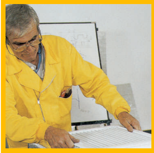
Prefabrik Klima Kanallarına menfezlerin takılması
