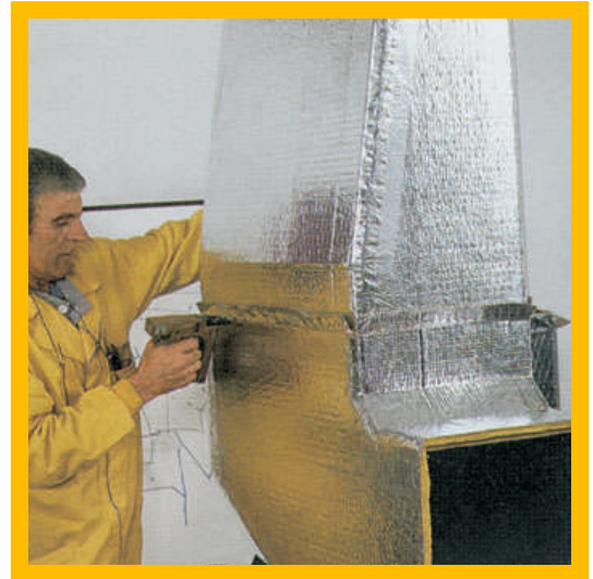
Prefabrik Klima Kanalları birleştirme yerlerinin zimbalanması
