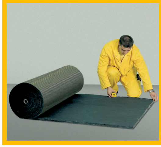
Izocam Akustik üzerinde alınan ölçü işaretlenir.
