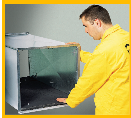
Kanal ebatlarında kesilmiş olan İzocam Akustik kanal yüzeyine yapıştırılır. Pimlerin pulları takılır ve fazla uzunluklar kesilir.
