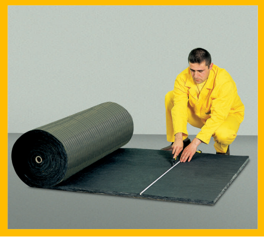
İşaretleli yerden İzocam Akustik kesilir.
