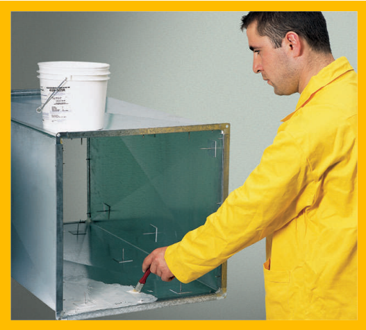
Kanal yüzeyine ASTM C 916'ya uygun yapıştırıcı bir fırça yardımıyla sürülür.
