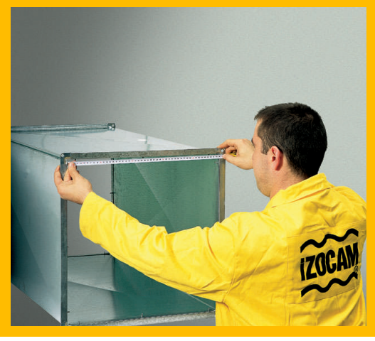
Yalıtım yapılacak kanalın içten içe ölçüsü alınır.
